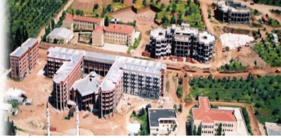
Kampüs İnşaatı - Mayıs 1997
