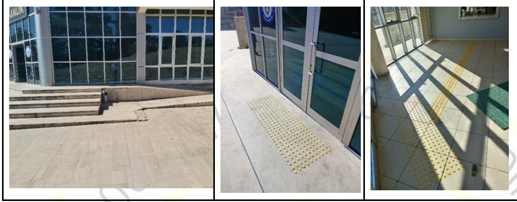
Şekil 7.5.4. a) Bina girişinde yer alan engelli rampası ve (b, c) görme engelliler için yer zeminindeki kabartmalar.
